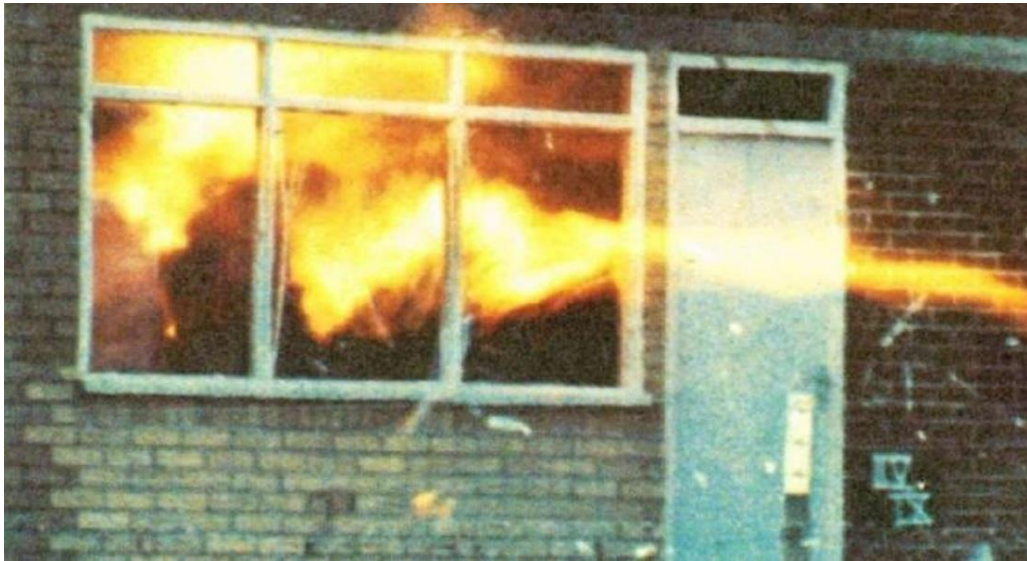
Figura 2 – Dinamica di esplosione di gas naturale all'interno di un'abitazione
